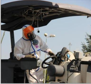
Jusqu'au début des années 90, certaines couches de roulement ont été réalisées avec des enrobés contenant de l'amiante (d'environ 1% de la masse sèche).
